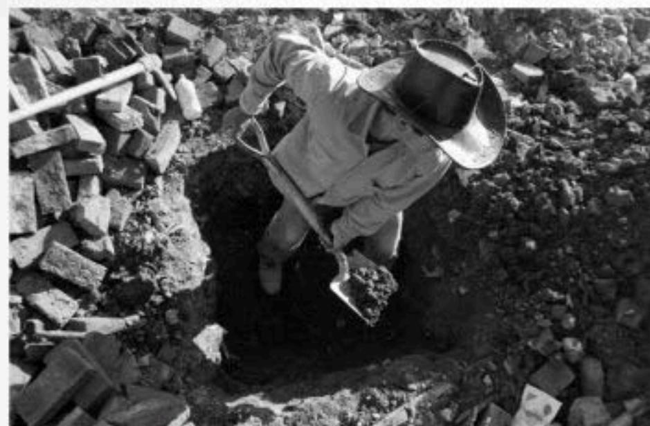
TOMA DE TIERRAS EN LOMAS DE ZAMORA (BS AS). Se inició en noviembre de 2008.
